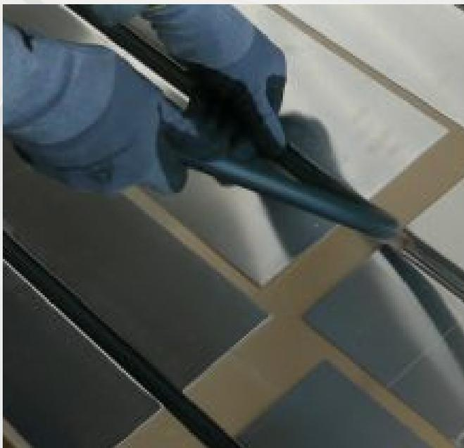
Toujours cintrer le tuyau avec une cintreuse ou en utilisant l'isolant comme gabarit
