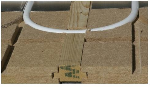
Le tuyau multicouche traverse la lambourde tous les 60 cm. 2 choix: Couper la lambourde (choix présenté) soit défoncer la lambourde avec une petite défonceuse manuelle équipée d'un fraise de 16mm.
