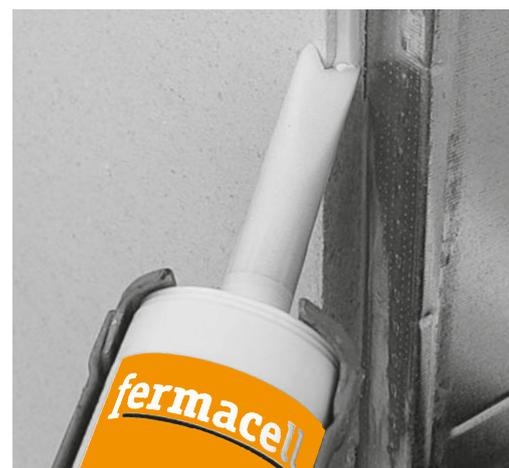
**Faire glisser la cartouche de 310 ml le long du chant de la plaque. L'embout spécial de la cartouche permet d'appliquer la quantité exacte de colle sur la largeur du chant de la plaque de 10 ou 12,5 mm. Pour les plaques 15 à 18 mm, on coupera l'embout**
