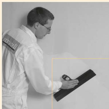
Surfacage à l'aide de l'enduit de lissage FERMACELL
